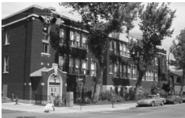
14.1.1 L'école Saint-Roch, au 7700, avenue d'Outremont
