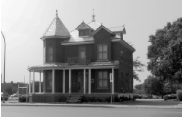
13.E.1 Maison Joseph-Gagnon (Galerie Port-Maurice)
