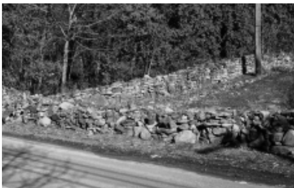
2.AP.1 Ce site rural de même que ce muret de pierre sèche sont des témoins éloquentes des occupations agricoles anciennes.
