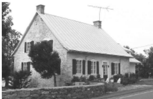
2.E.3 La maison Augustin-Brisebois, au 18639, boulevard Gouin Ouest
