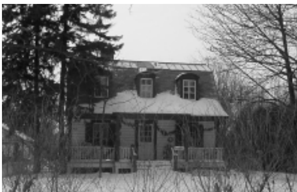
2.E.2 Le 9436, boulevard Gouin Ouest
