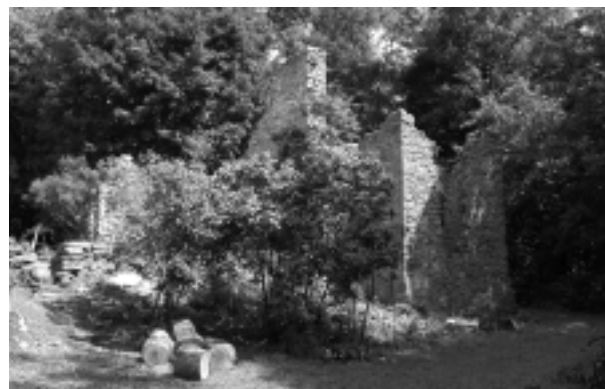
BiFI-002 Le site archéologique du fort de Senneville en cours de relevé et de mise en protection, 2004. Photographies: ministère de la Culture et des Communications du Québec.
