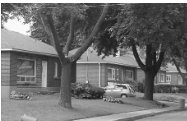
27.U.3 Les bungalows recouverts de brique entre la rue Gustave-Bleau et place Lepailleur
