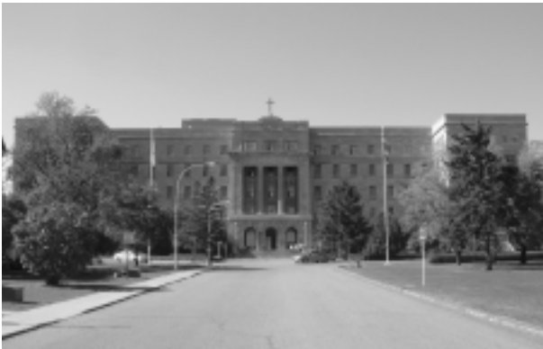
27.E.4 L'hôpital Louis-H.-Lafontaine, pavillon Ignace-Bourget (Crédit photographique: Denis Tremblay, 2002)
