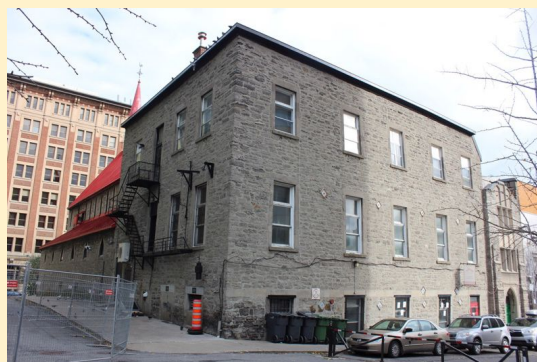
Ancienne école Photo : BRODEUR CONSULTANTS
