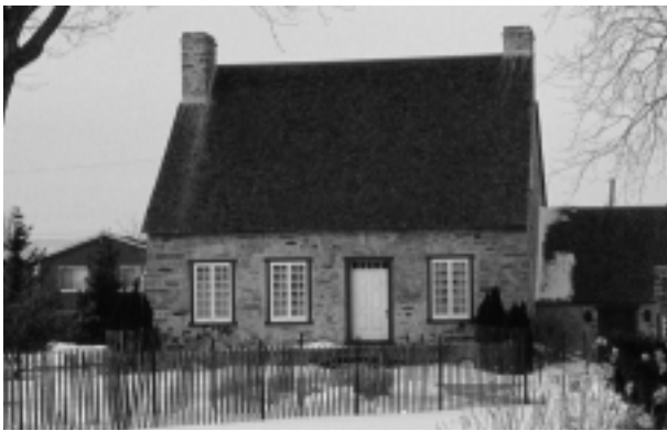
La maison Lantier, rare témoin d'un mode de vie rurale.
