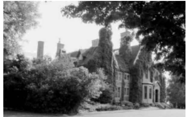
7.E.5 Bâtiment principal et pavillon d'entrée
