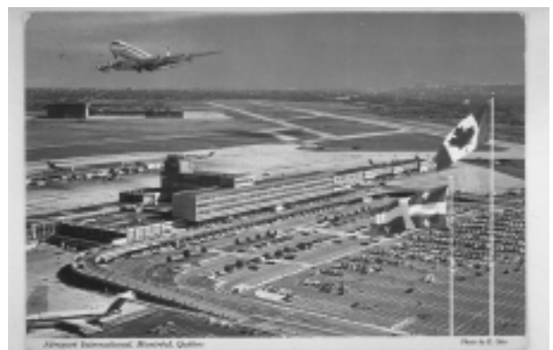
Vue aérienne de l'aéroport international, sans date, http://www.bnquebec.ca , Collection Cartes postales, CP 2590
