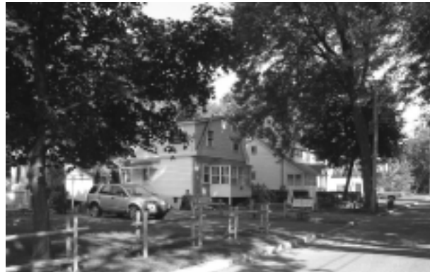
7.1.1 Avenue Saint-Charles, vue générale
