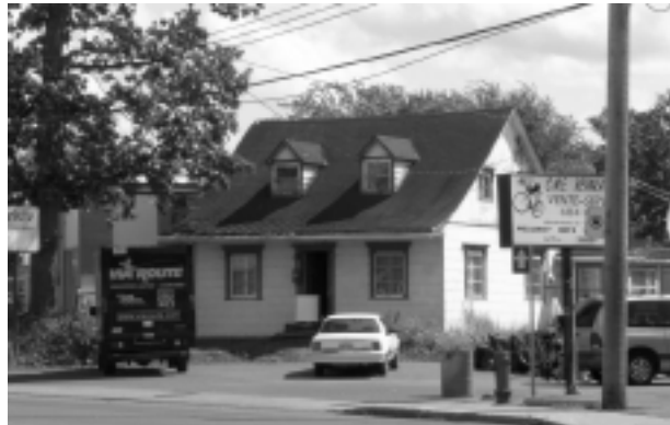
10412, boulevard Gouin Ouest
