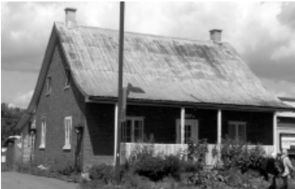
11407, boulevard Gouin Ouest
