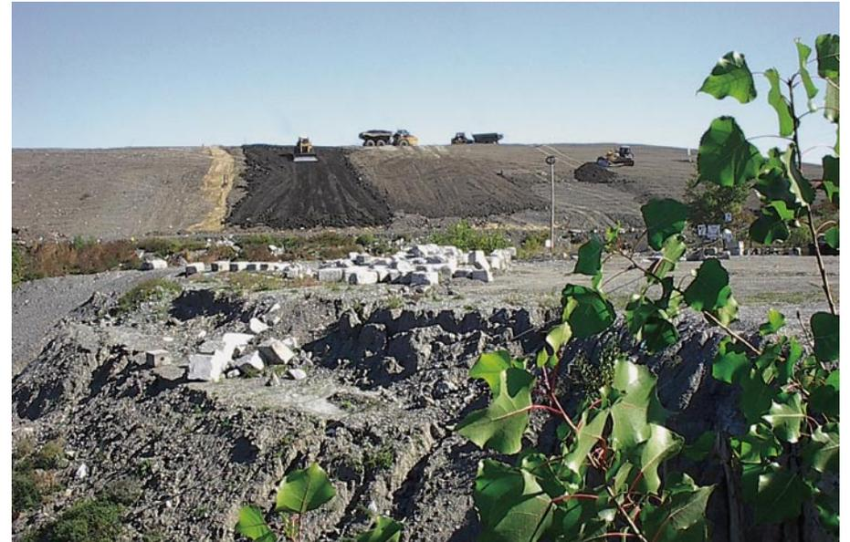
Pour ce qui est des 200 000 tonnes de matériaux d'excavation produites par les travaux municipaux, il est prévu de poursuivre l'utilisation des matériaux récupérables (terre, roc et béton) à des fins de recouvrement final et de remblai au Complexe environnemental de Saint-Michel (CESM), en vue de la création du futur parc métropolitain qui y est prévu en 2020.
