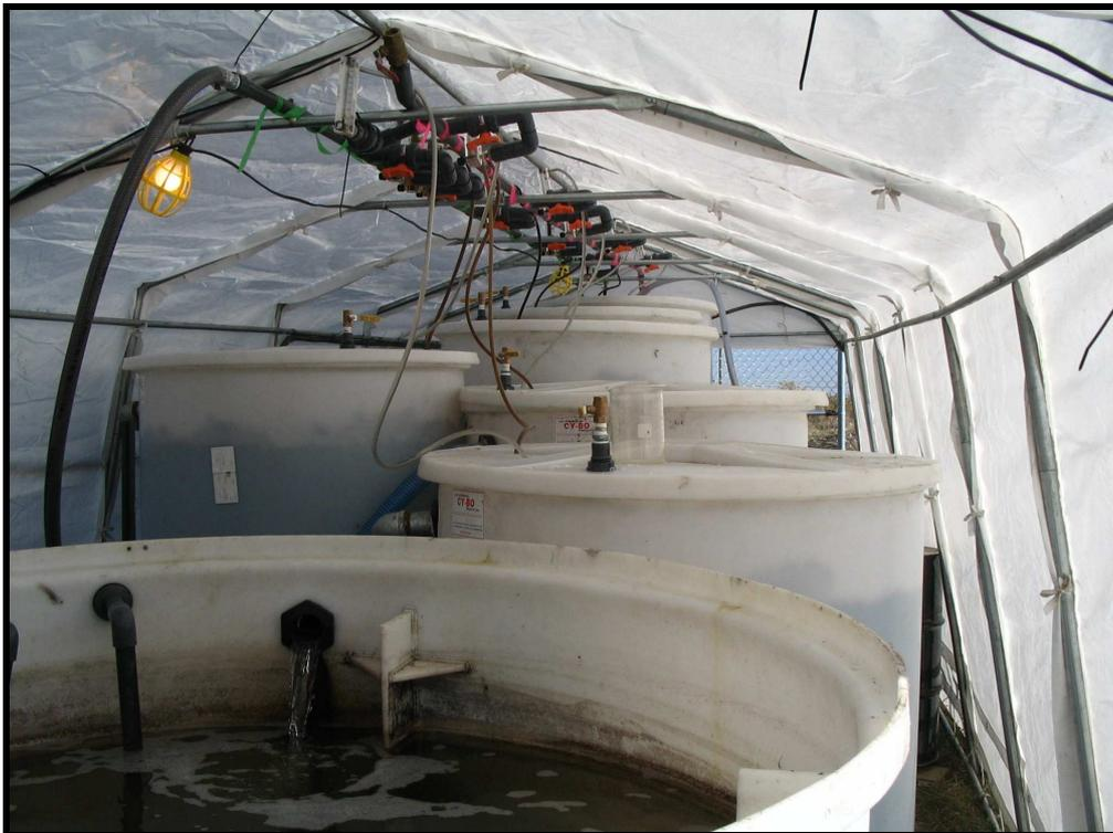
PHOTO 2 : VUE DU BASSIN DE RECIRLUTATION ET DES BIORÉACTEURS
