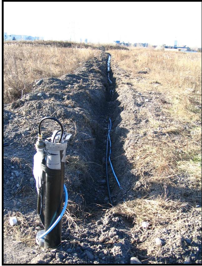
PHOTO 3 : VUE DES INSTALLATIONS POUR LE POMPAGE DES EAUX BRUTES POUR LE TRAIN DE TRAITEMENT *MULTI-POINTS*
