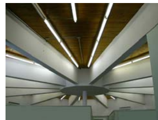
Fig. 7 Vue du plafond (2005)
