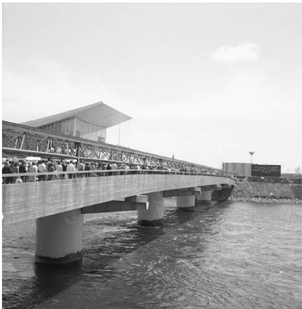
Fig. 2 Passerelle du Cosmos (1967)
