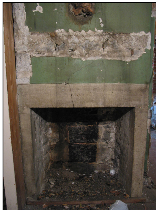
Figure 2.12. La cheminée est au rez-de-chaussée du 4251, boulevard Gouin Est, 2006
