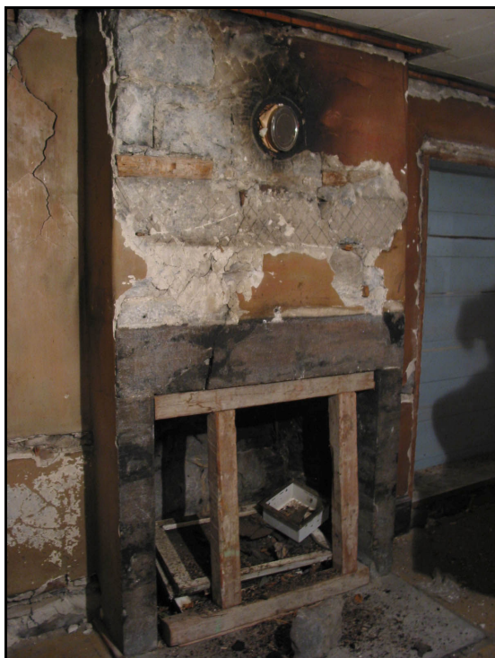
Figure 2.11. La cheminée ouest au rez-de-chaussée du 4251, boulevard Gouin Est, 2006
