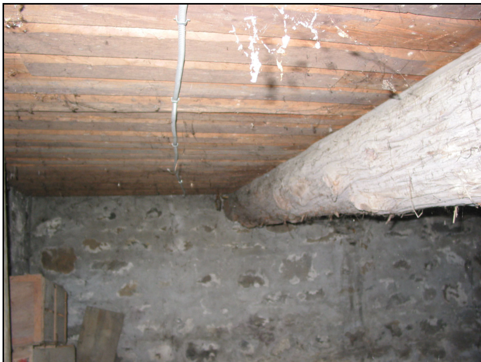
Figure 2.9. Poutre du plancher du rez-de-chaussée, 4251, boulevard Gouin Est, 2006
