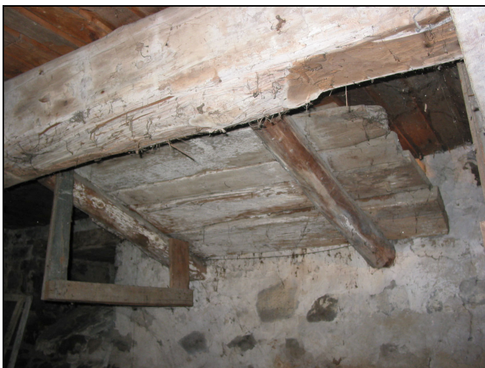
Figure 2.10. Structure en gros bois supportant le foyer ouest, 4251, boulevard Gouin Est, 2006
