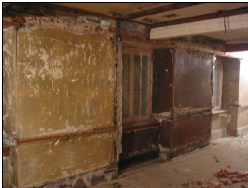
Figure 2.13. Mur arrière au rez-de-chaussée, 4251, boulevard Gouin Est, 2006
