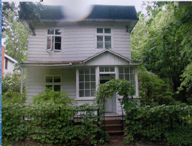
FAÇADE SUR RUE ST-RÉAL
