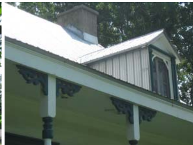
Fig. 13 : Lucarne et avant toit
