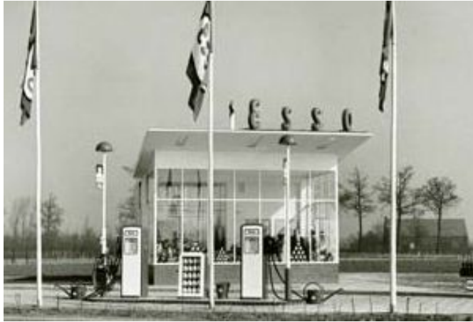
La station Dudok à Leende, à une près, la plus petite avec sept fenêtres et un îlot de pompe.
