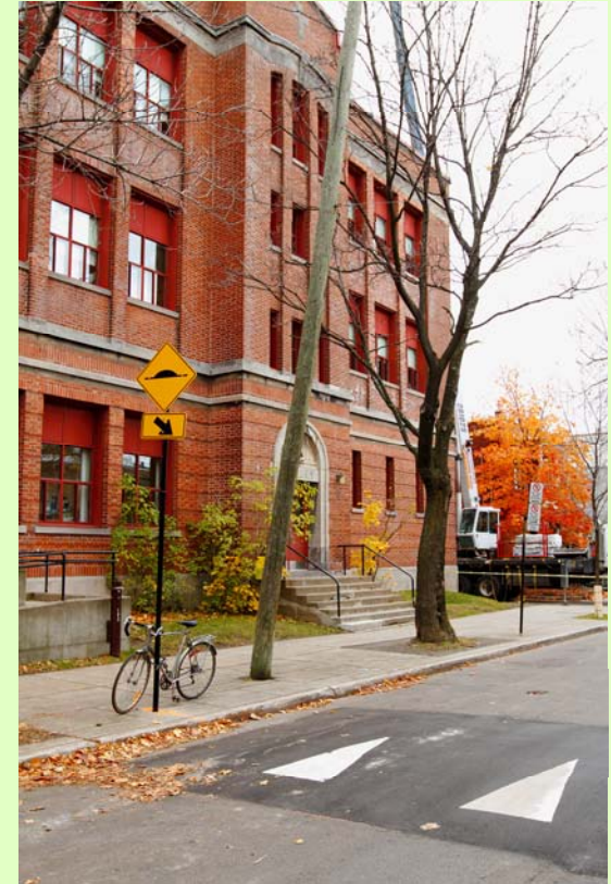
Travaux d'apaisement de la circulation devant l'école Hélène-Boullé
