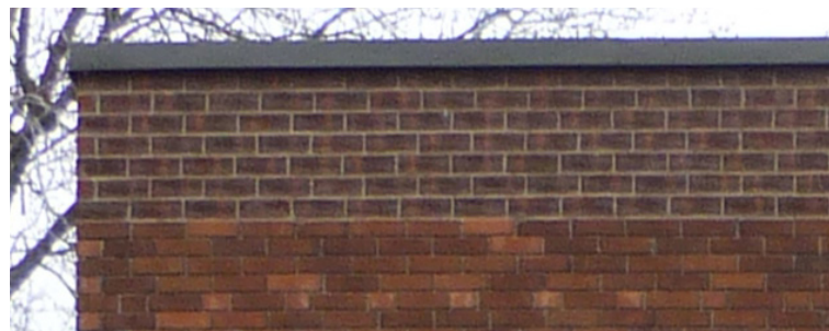
◆ ◆ Corniche et parapet trop simplifiés en relation avec le caractère de la façade d'origine (à éviter)
