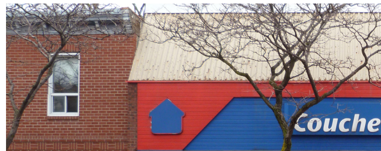
■ ◆ Absence de fenêtre. Façade aveugle qui aurait tout avantage à être ouverte pour dynamiser la composition (inadéquat)
