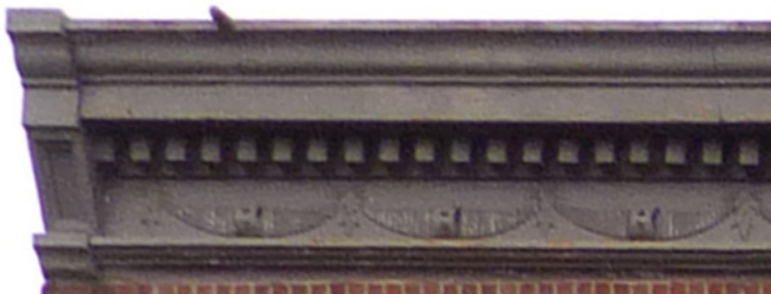
P ● Corniche en tôle moulurée (à préserver)
