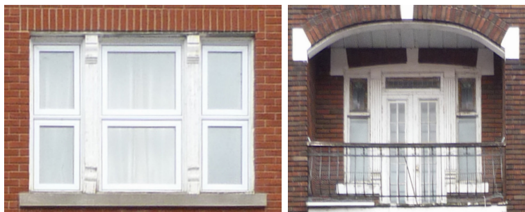
P ● Ouvertures d'origines (à préserver)
