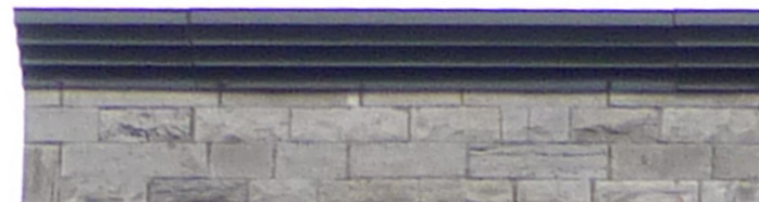
● ● Corniche en tôle moulurée reconstituée
