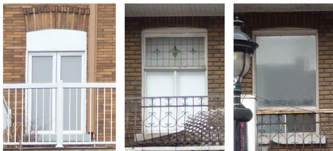
◆ Fenêtre/porte rectangulaire dans une baie cintrée (à éviter) P ■ Imposte en bois avec vitraux (à restaurer) ◆ Fenêtres de bois remplacées par PVC ou aluminium (à éviter)
