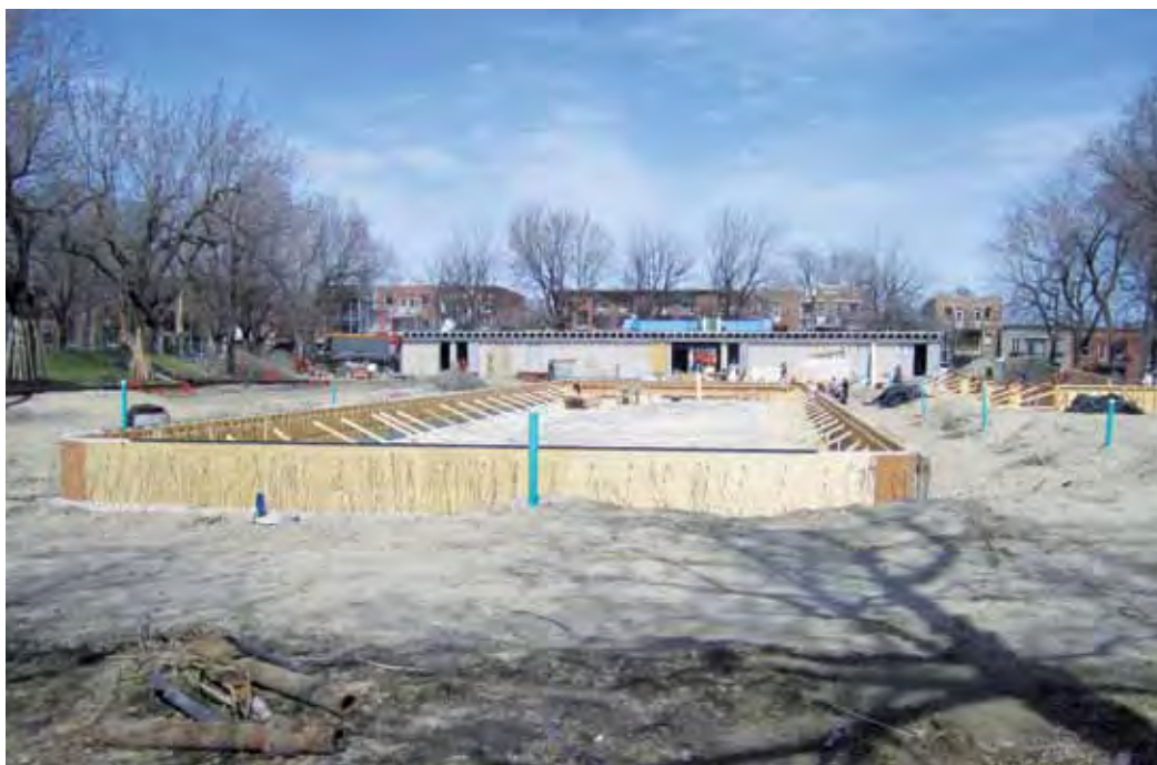
Chantier de la piscine Laurier en avril.
