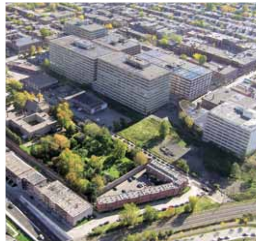
Vue aérienne des mégastructures
