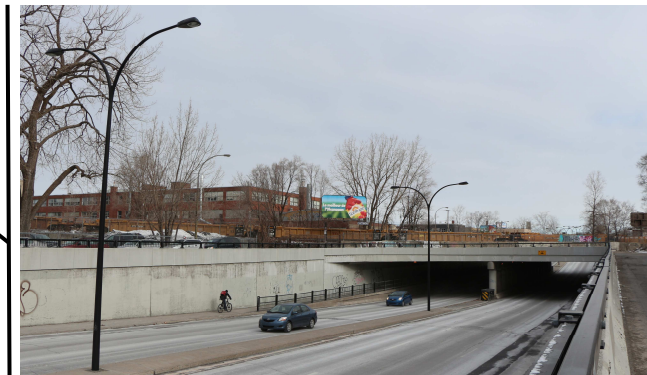
Viaduc rue Masson
