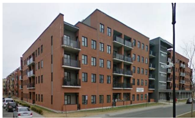
Les Toits de Mercier – redéveloppement du site Alcatel (126 log) Rue Hochelaga – district de Tétéraultville
