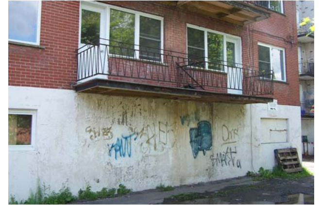
Graffitis sur la façade nord d'un immeuble d'habitations
