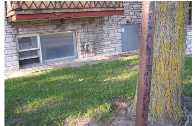
Logement en demi-sous-sol nécessitant des réparations majeures
