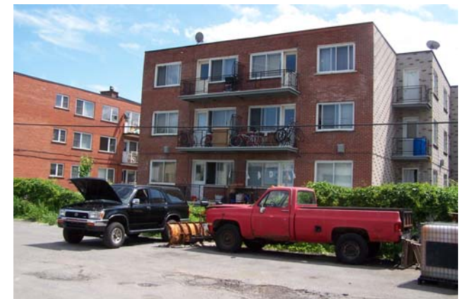
Espace asphalté sur la portion industrielle du terrain
