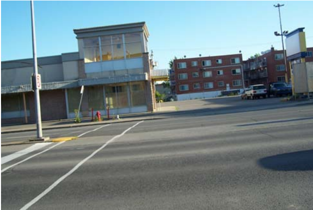
Vue sur l'ancien IGA en location
