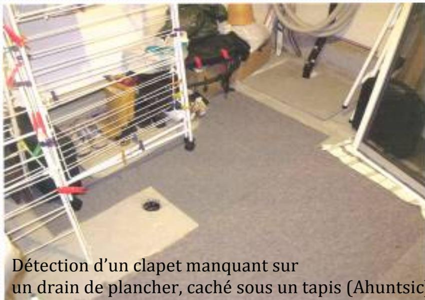
Détection d'un clapet manquant sur un drain de plancher, caché sous un tapis (Ahuntsic)
