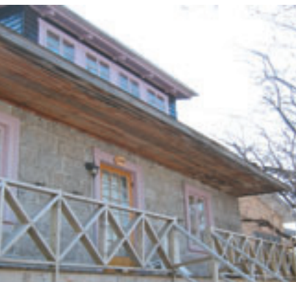
Le relèvement du rez-de-chaussée pallie à l'accumulation de neige.
