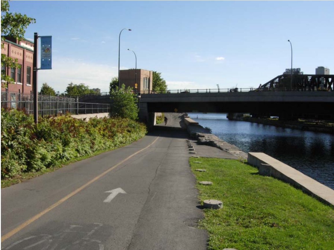
Piste cyclable sous le pont Wellington Notez la faible largeur de l'emprise
