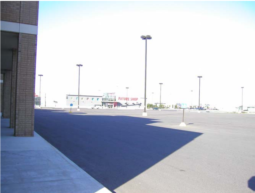
Pôle commercial Angrignon en 2004 Absence de bordures et trottoirs
