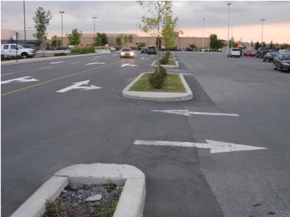
Pôle commercial Angrignon en 2007 Travaux correctifs pour mieux diriger la circulation Construction d'îlots séparateurs et de trottoirs en 2007.
