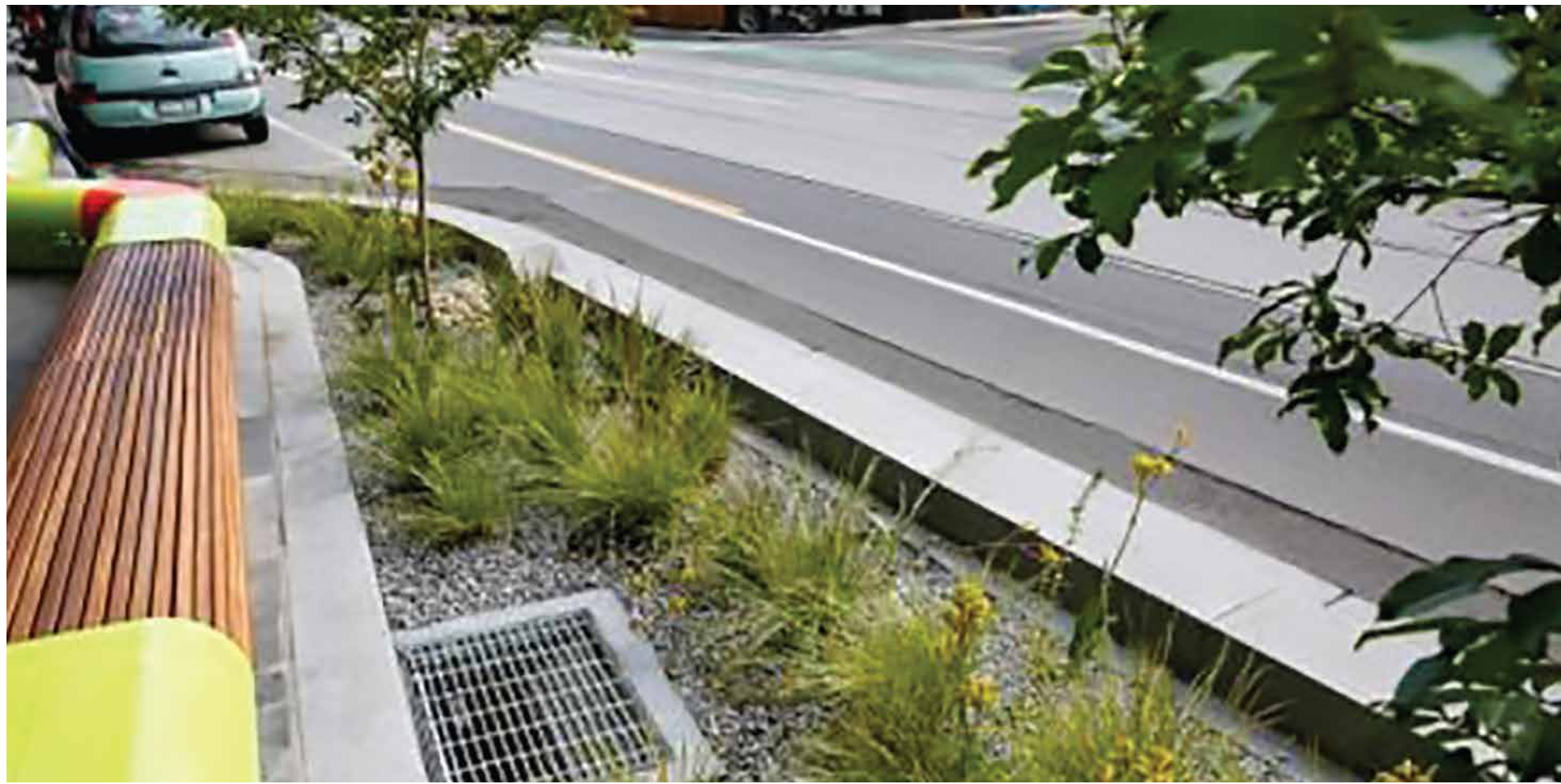
Espace de biorétention, rue Chapel Melbourne, Australie Source : City of Stonnington
