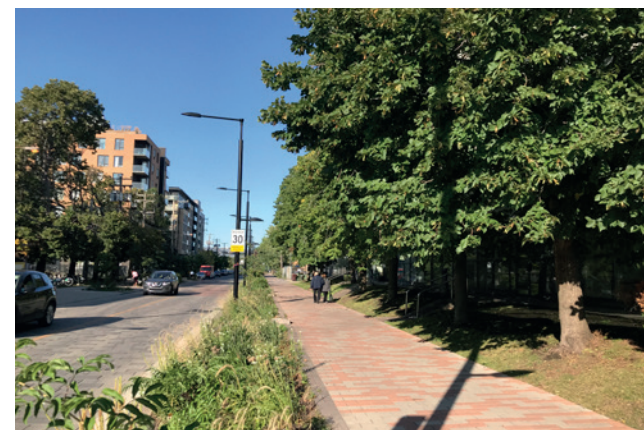
Gestion des eaux pluviales intégrée au trottoir, quartier Le Triangle, arrondissement de Côte-des-Neiges—Notre-Dame-de-Grâce
