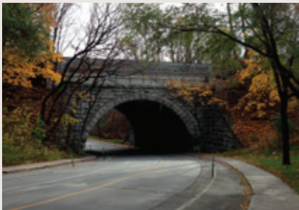
Le viaduc du chemin Glen, à Westmount
