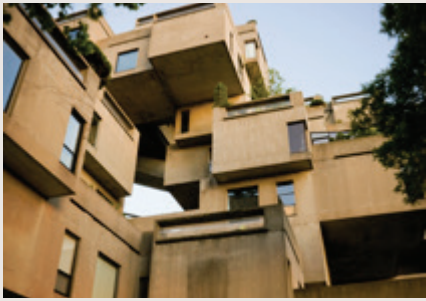
Habitat 67, patrimoine moderne
