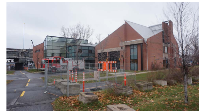
Caserne de pompiers
