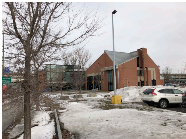
Trottoirs manquants le long du boulevard René-Lévesque
