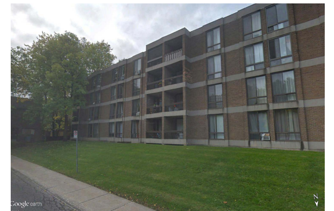
Immeuble résidentiel au centre de l’île (Source : Google, 2019)
