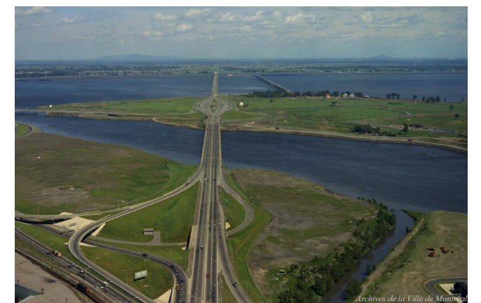
Construction du pont Champlain dans les années 1960
