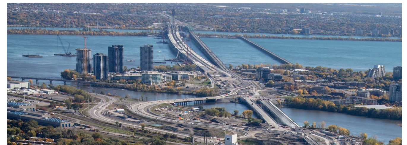
Chantier pour le nouveau pont Samuel-De Champlain et vue sur une partie de l'autoroute Bonaventure (Source : Infrastructure Canada)
