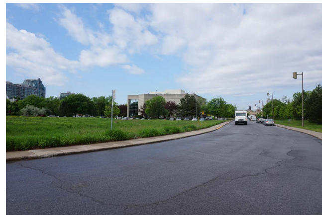
État actuel de la rue Levert
