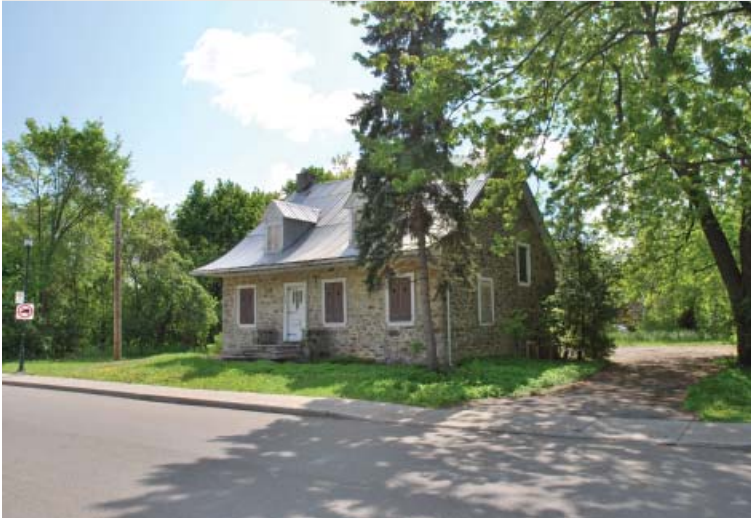
Site de la maison Robert-Bélanger (Source : Ville de Montréal, mai 2012)
