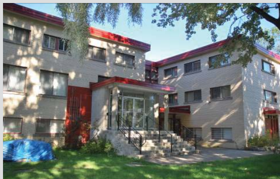
Entrée principale de la résidence Roger-Marien (Source : Ville de Montréal, septembre 2013)
