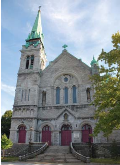
Façade de l'église Saint-Eusèbe-de-Verceil (Source : Ville de Montréal (VDM), septembre 2012)
