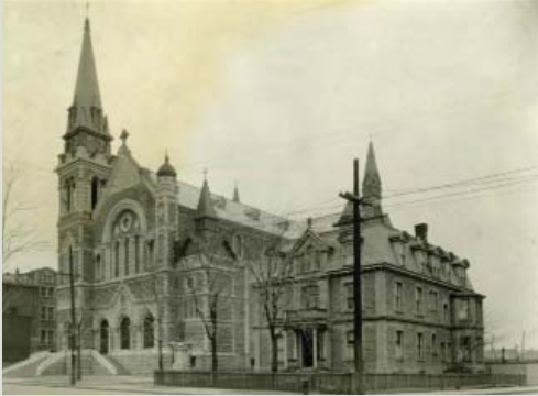
Église Saint-Eusèbe-de-Verceil, 1930 (Source : collection Félix Barrière, BAnQ)
