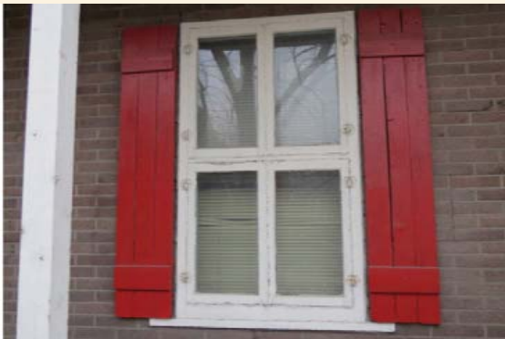
Fenêtre à battants en bois d'origine. Les contrevents peints en rouge ont été ajoutés après 1981. (Source : Colin Fraser, architecte, février 2014)
