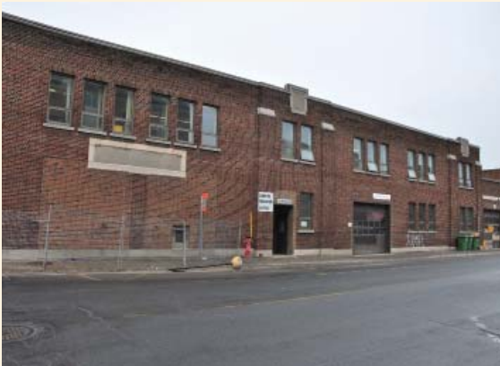
Façade du bâtiment 2 (source : Ville de Montréal, avril 2016).
