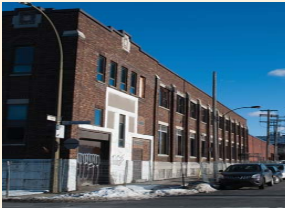
Façade du bâtiment 1 sur l'avenue De Gaspé (source : L'Enclume, mars 2016).
