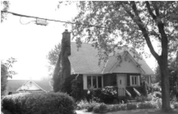
5.U.2 Le 105 de l'avenue de Windward Crescent
