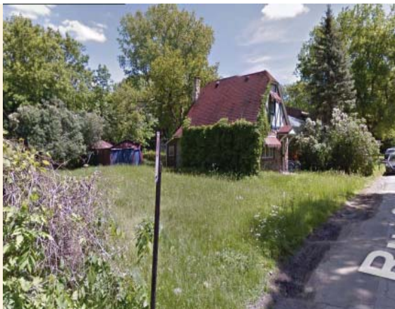
Bien visible à l'entrée du parc-nature, le bâtiment prend l'allure d'un pavillon du parc. Source: Google Maps, 2016
