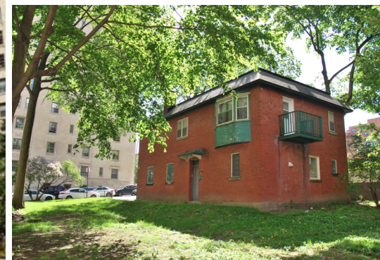
Le site de l'ancien coach house
