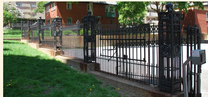
Clôture de l'ancienne propriété MacKenzie repositionnée derrière la tour et délimitant l'aire de stationnement.
