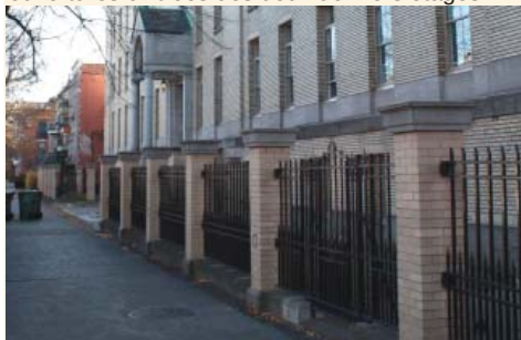
La clôture et ses colonnes de briques ceinturant la cour avant du monastère sur la rue Saint-Hubert.
