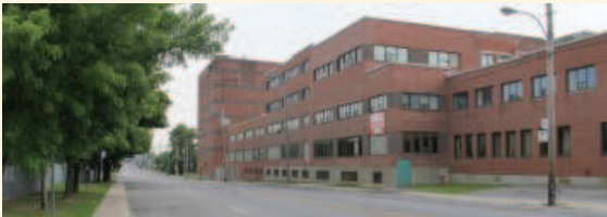
Façade du complexe sur l'avenue Lafleur (Source : Lafontaine Soucy, 2016)
