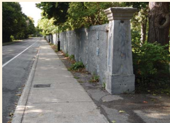
Mur d'enceinte sur le boulevard Gouin Est
