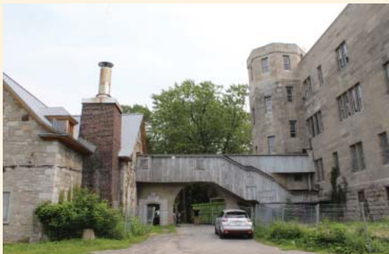
Passerelle reliant le corps principal et la chaufferie Source : Passerelles coopérative en patrimoine
