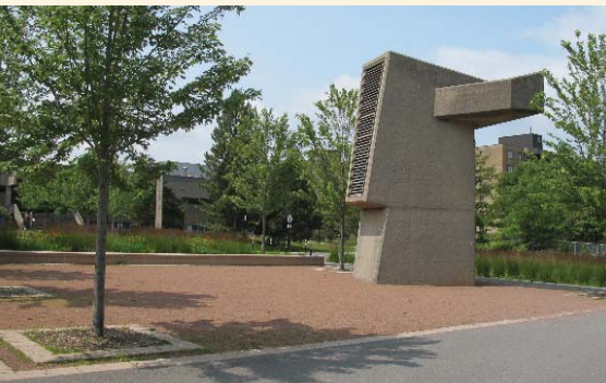
Cette tour de ventilation est intégrée au paysage et résulte d'une collaboration fructueuse entre architectes, architectes paysagistes et artiste sculpteur.
