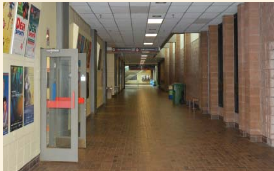
Des matériaux d'origine encore présents: les blocs de béton des murs, les carreaux des planchers.
