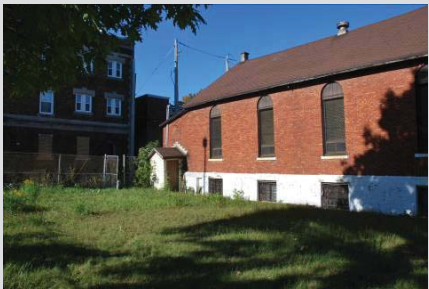
La façade latérale sud de l'église (source : Ville de Montréal, septembre 2012)
