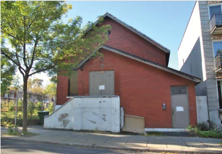
Église de Dieu Centrale de Montréal (Source : Ville de Montréal, sept. 2012)
