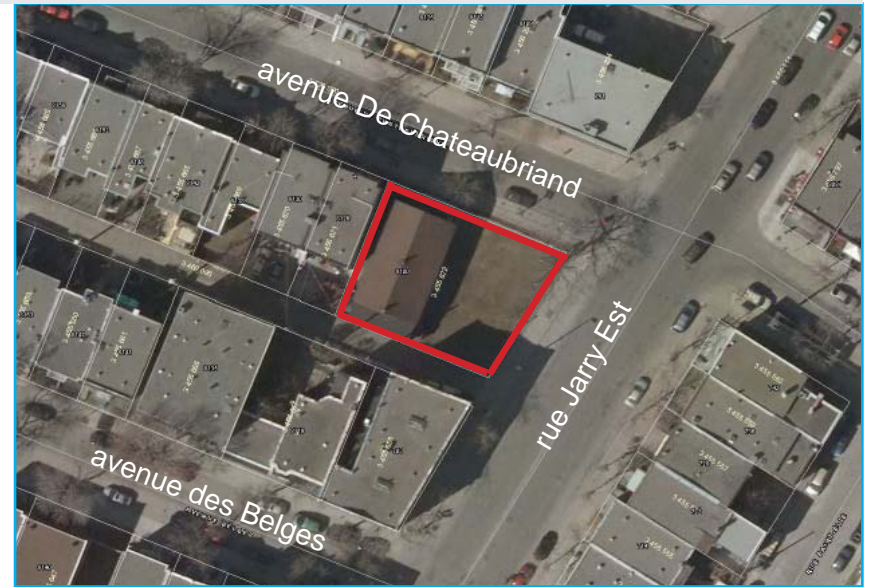
Photo aérienne du secteur (Source : Ville de Montréal, 2009)
