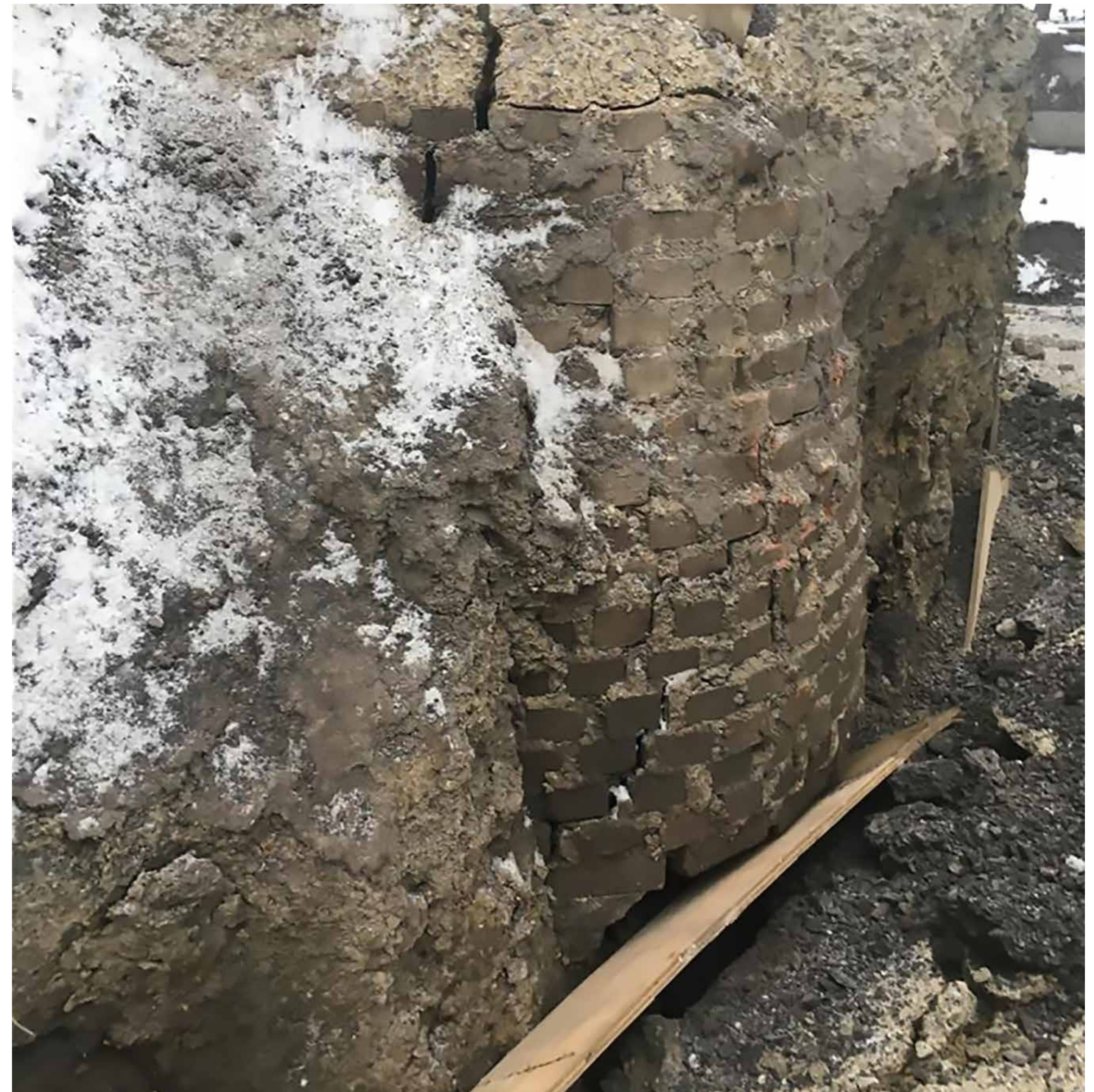
Regard d'égout en brique (compartiment par lequel on accède aux égouts pour les nettoyer, les inspecter et les entretenir)
