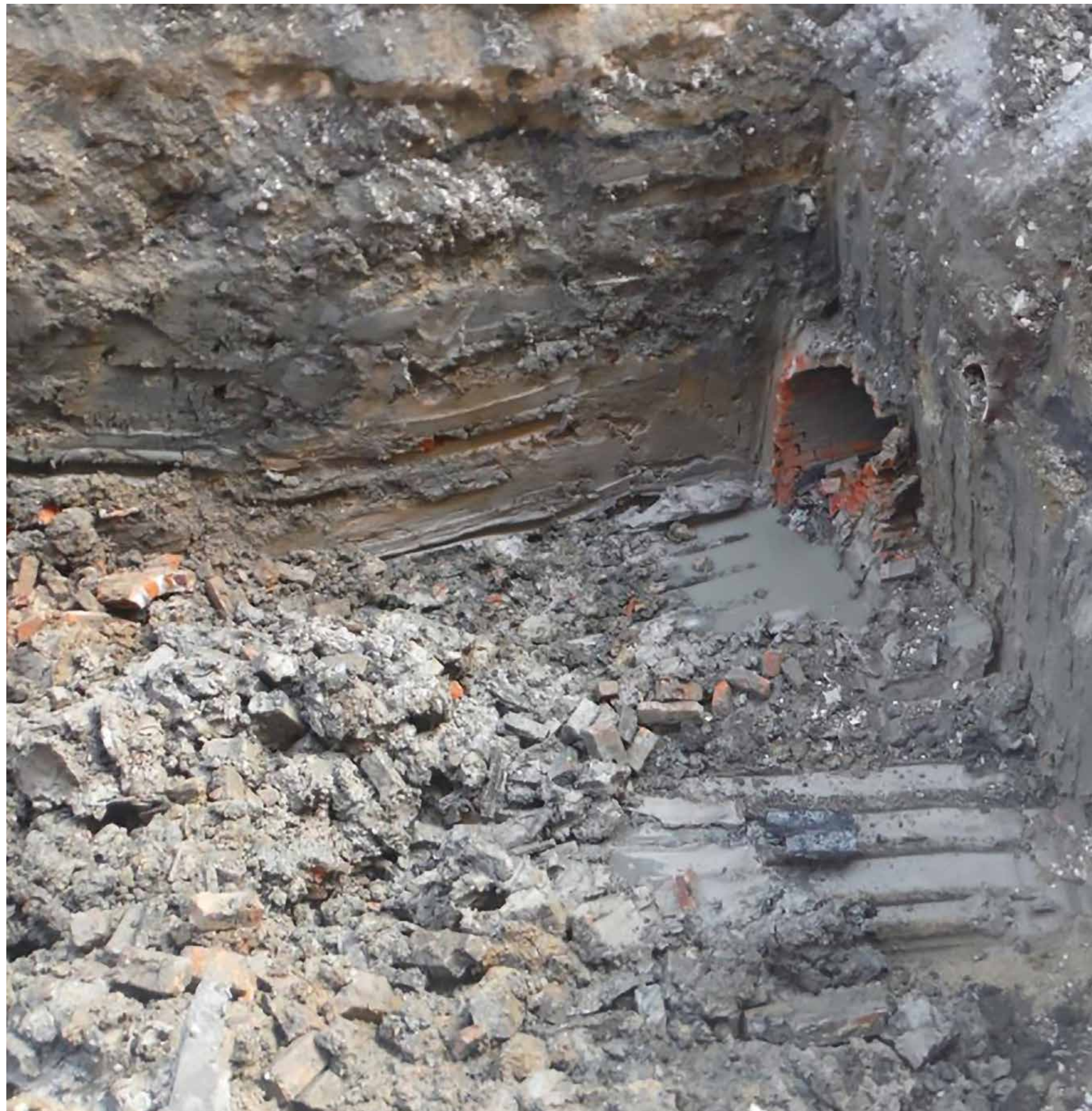
Conduite d'égout en brique
