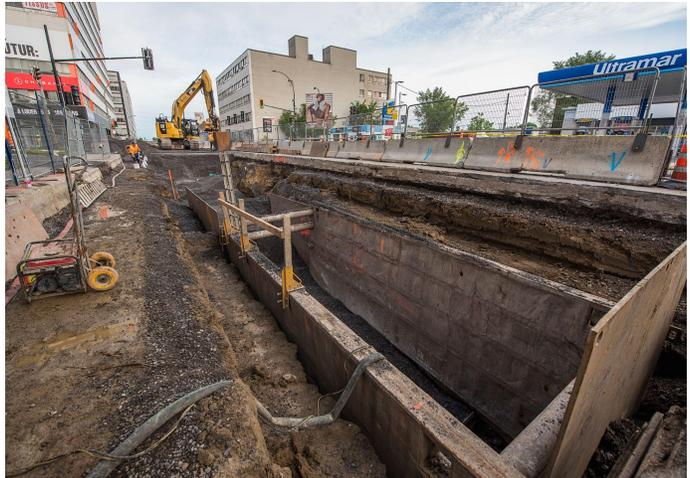
Cette méthode nécessite l'excavation d'une portion de la rue afin de creuser une tranchée pour y installer la conduite. À la fin des travaux, la rue est reconstruite.
