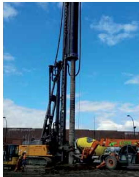
Les pieux mis en place autour du puits permettent de sécuriser et d'étanchéiser les parois de sol afin d'atteindre le rocher en profondeur pour débiter les travaux de forage du tunnel. En tout, 74 pieux devront être forés, en plusieurs phases, selon la technique de double rotation, avec une grue spécialisée pour ce type d'ouvrage.
