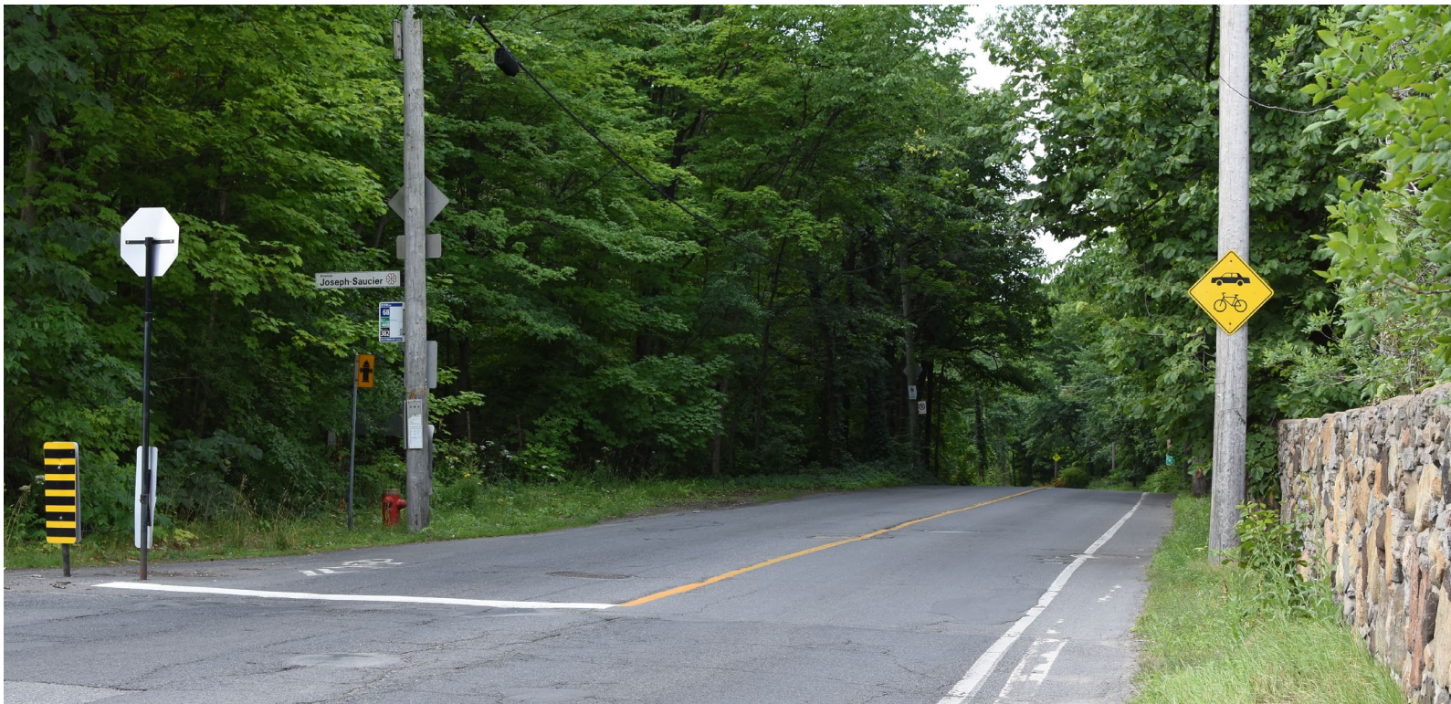
Début du parc-nature du Bois-de-Saraguay, à l'intersection de l'avenue Joseph-Saucier et du boulevard Gouin Présence problématique des lignes électrique aériennes à proximité de la chaussée et absence d'aménagement aux arrêts d'autobus
