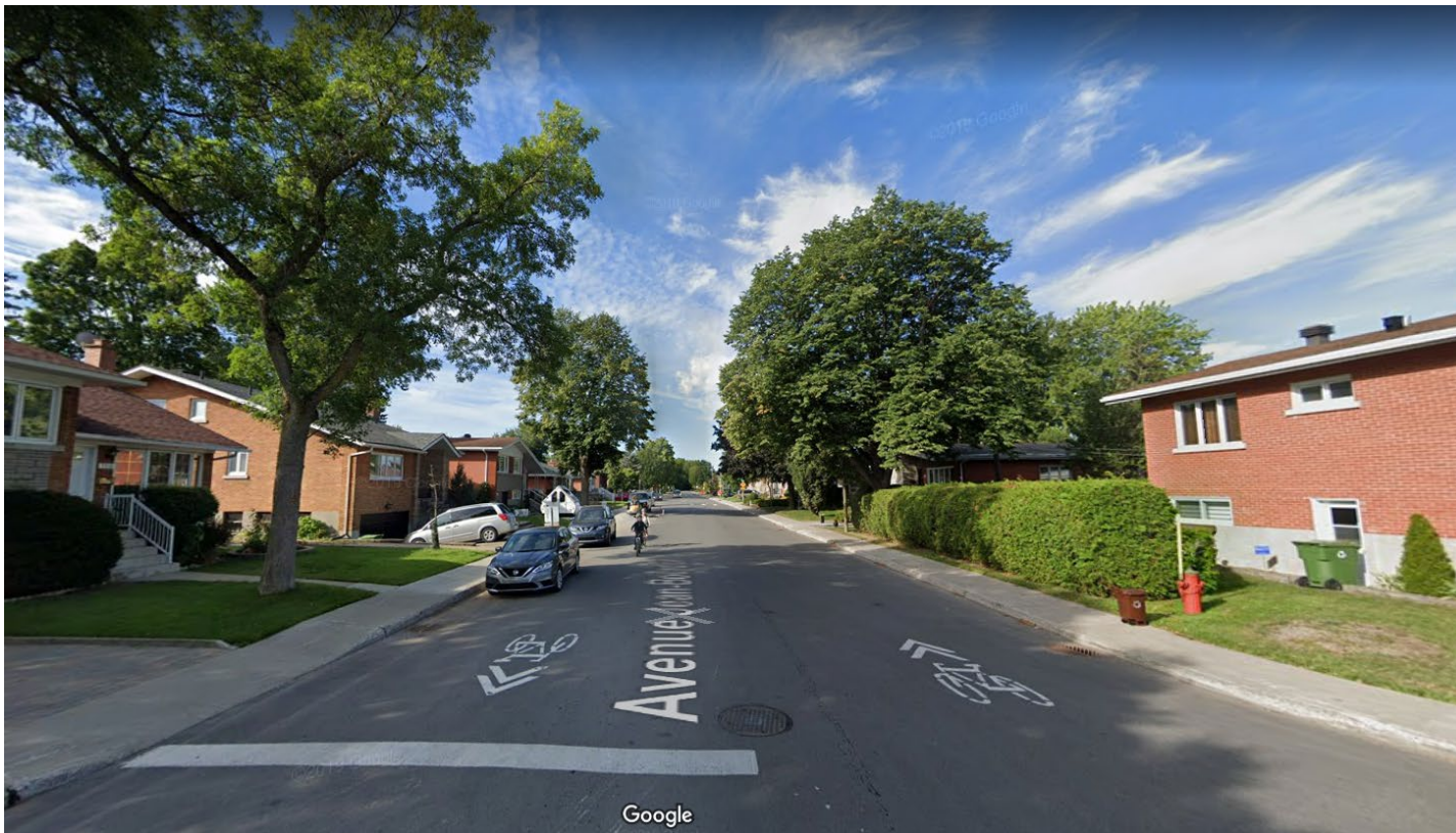
Zone résidentielle – l'avenue Jean-Bourdon Trottoir étroit et chaussée désignée
