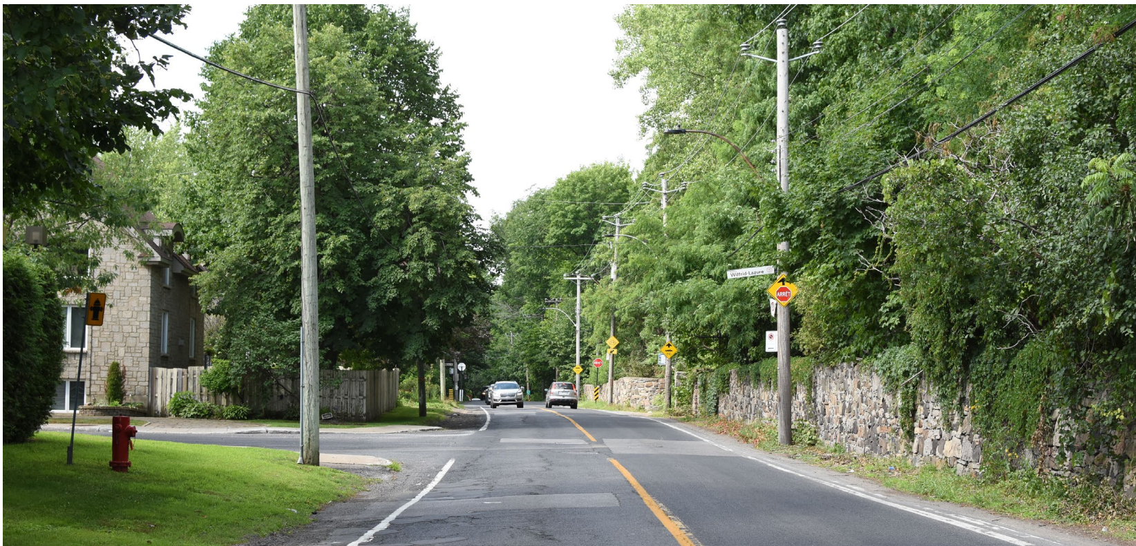
Zone résidentielle, à l'intersection de l'avenue Wilfrid-Lazure et du boulevard Gouin Mur patrimonial en pierre et les lignes de fils électriques aériens près de la chaussée
