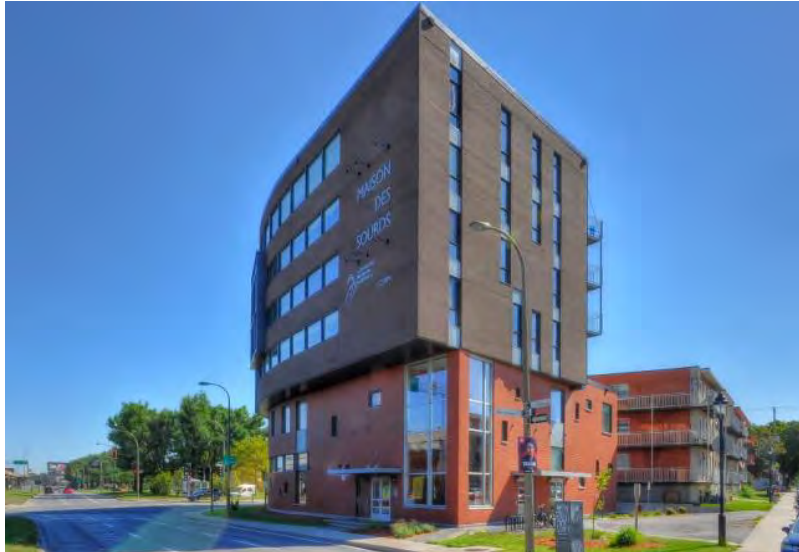
Vue sur l'immeuble de 34 logements avec ascenseur qui abrite les espaces communautaires ainsi que logements de type studios ou 3 1/2 pour des personnes vivant seules. Crédit photo : Ville de Montréal
