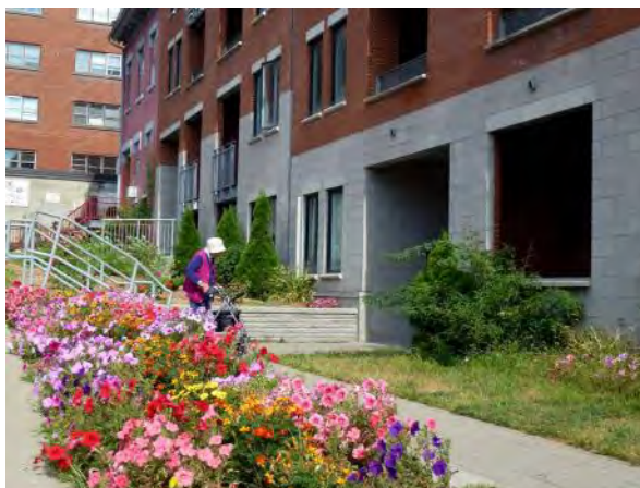
Vue sur le Centre Yee-Kang à partir de la rue de Bullion. Crédit photo : Ville de Montréal
