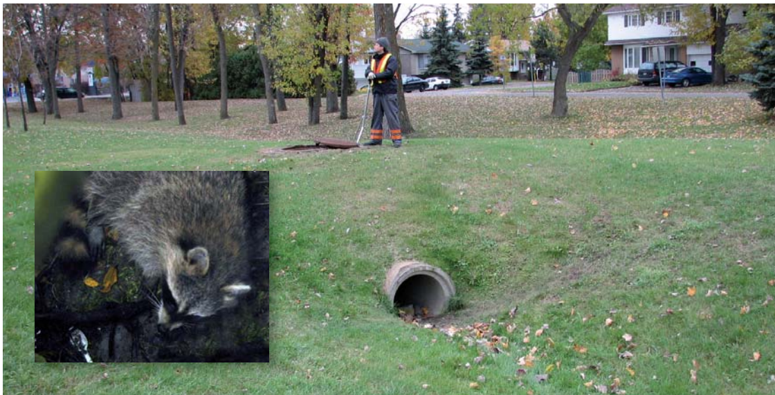
Les animaux ont accès au réseau d'égouts pluviaux du ruisseau Meadowbrook.
