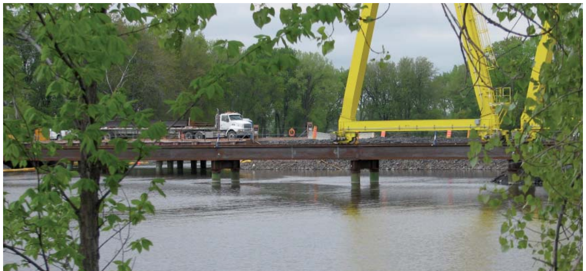
Construction de l'Autoroute 25 à la hauteur de la 4 e avenue, Rivière-des-Prairies-Pointe-aux-Trembles.
