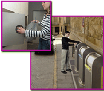
Système de collecte pneumatique (par aspiration) de la compagnie Plastic Omnium
